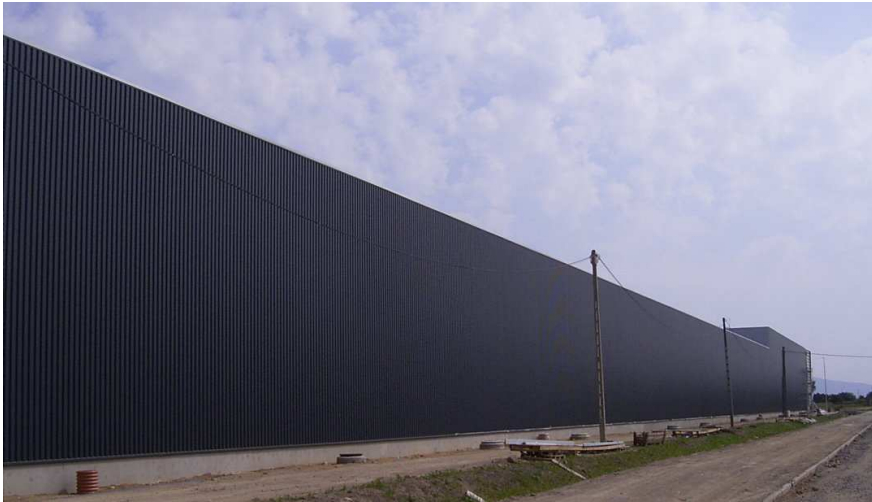
Die SolarWall Fassade an der Fertigungs- und Versandhalle
