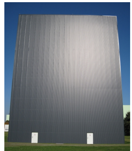
Westfassade als SolarWall Kollektor
