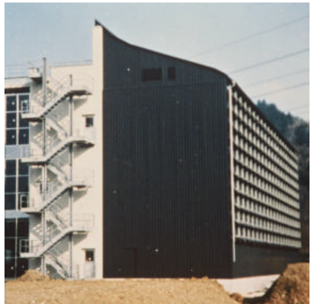
Drei Seiten des Lagers dienen als Luftkollektor South-East-and Westside are collecting solar heat
