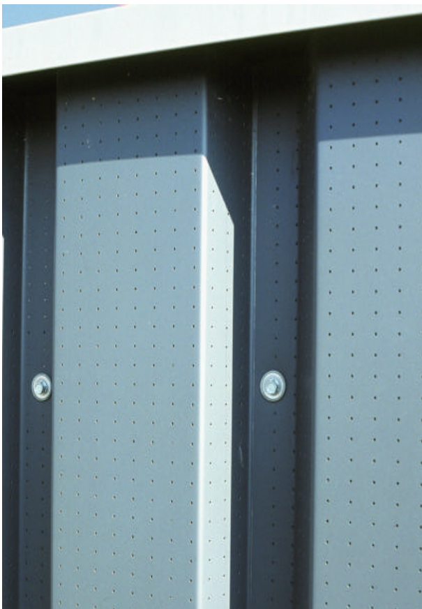
Funktionsprinzip SOLARWALL: ein von Luft durchströmter Absorber sammelt solare Wärmepolster
